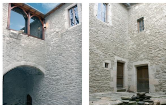
Détails des moulures d'une fenêtre à croisée et de portes avec un arc en accolade et un linteau à moulure simple (fin Moyen Âge).
