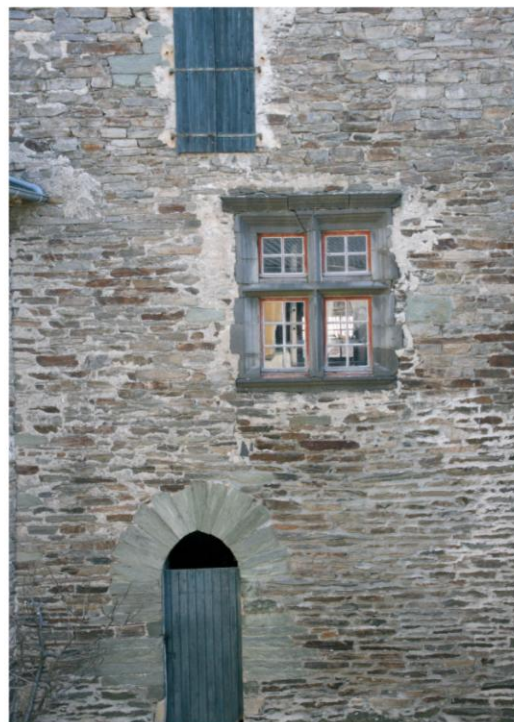
Donjon, côté cour, percé, au rez-de-chaussée, d'une porte à arc brisé.
