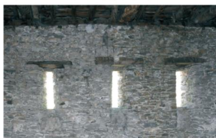
Vue intérieure des meurtrières (bâtiment annexe).
