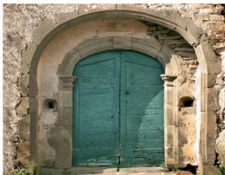
Porte d'entrée de la cour intérieure (datée 1546), protégée par un assommoir et deux bouches à feu.
