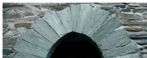
Détail des claveaux de schiste vert de l'arc brisé.
