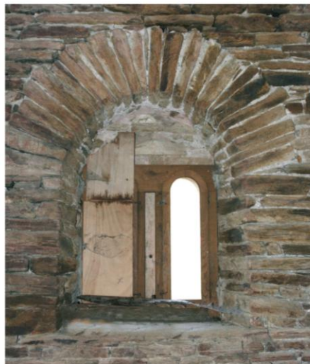
Intérieur d'une baie romane, couverte d'un arc en plein cintre à claveaux de schiste (mur nord de l'église).
