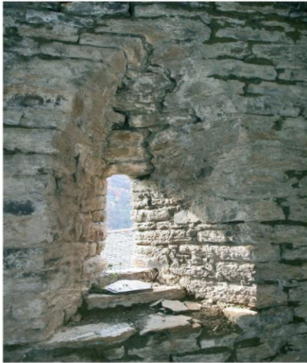
Ébrasement intérieur d'une meurtrière du logis.
