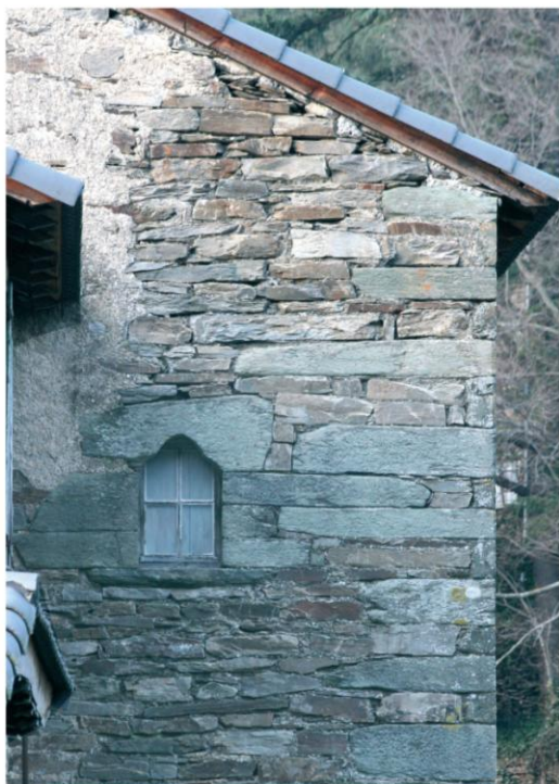
Baie médiévale couverte d'un linteau monolithique trilobé.
